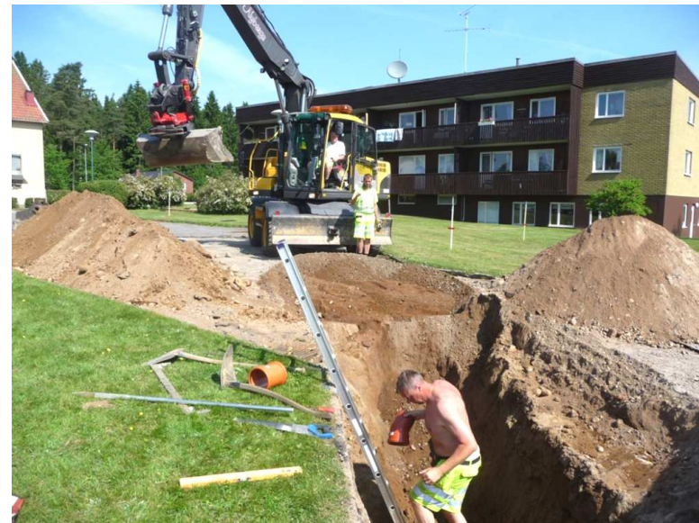
Ombyggnaden börjar med att lägga dagvattenledning. Här är Anders Lindgren på väg ner i gropen för att prova om rörböjen passar.
